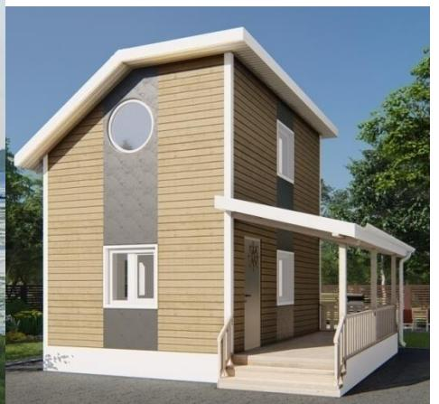
необходимо учитывать размер сайдинга 3600мм ( $200+3600+200=4$ м ширина здания). Свесы кровли могут быть небольшие от 200 до 400мм. Подшивка кровли помимо софитов возможно тем же крашенным ЦСП при условии создания вентиляции фасада в подкровельное пространство в случае зимнего утепления дома.
