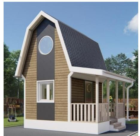
Формы кровель более плоские, в наклонной кровле - софиты кровли в примыкании со стеной делаются наклоном перпендикулярно кровле и подчеркиваются при наличии угловым белым элементов фасада. Навесы веранд могут иметь наружный наклон лицевых стоек и перил перпендикулярный или больший наклону кровли. Угловые вставки и обрамления торцов кровель достаточно в половину меньше 200мм (по размеру ветровой пластиковой планки +
